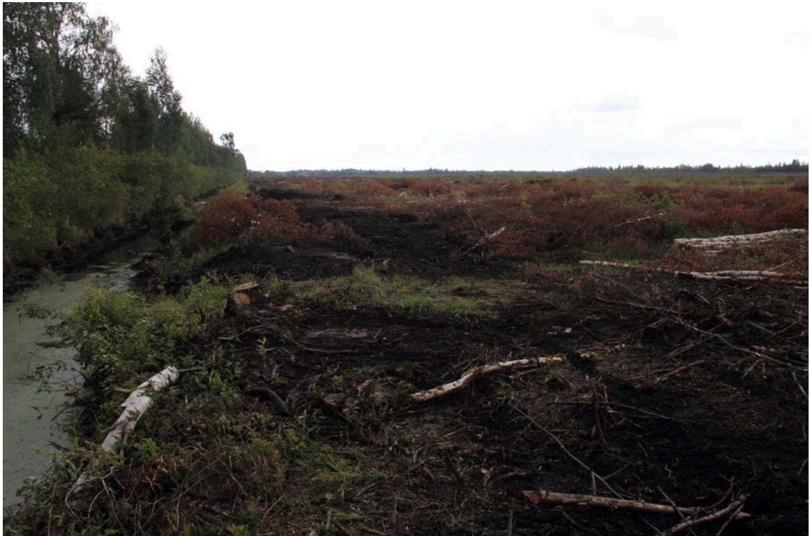
7. attēls. Novākts kokaugu apaugums un veikta grāvju tīrīšana un padziļināšana teritorijas austrumu malā.
